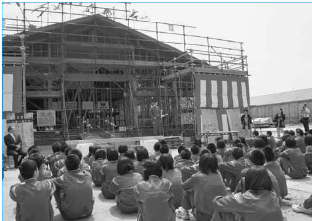
在校生が校舎棟の完成を待ちわびた「井川中学校上棟式」
