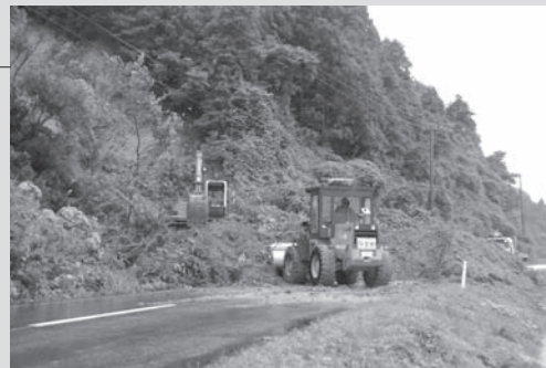
◀大台～井内間土砂崩れ
