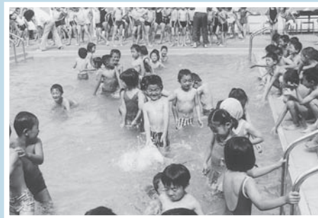
「小学校プール」 この年完成しました
