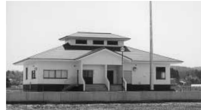
農業集落排水処理施設(施田地区)
