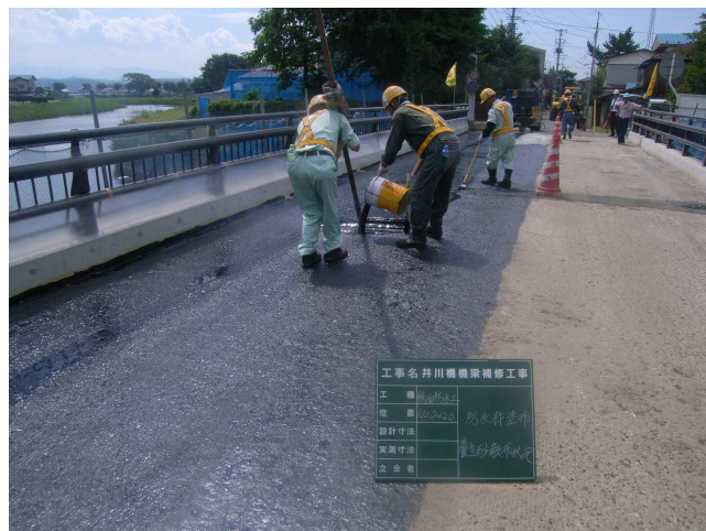
「橋面防水工：橋面防水層散布状況」
