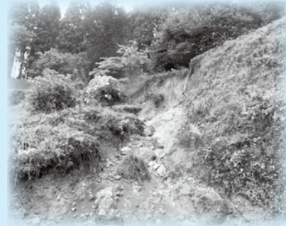
平成25年7月、井内町内で大雨により民家の裏山が一部崩落。
