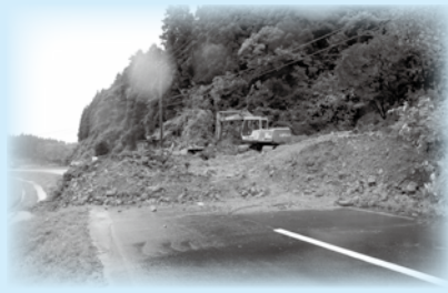
平成21年7月、大雨による山崩れで県道北ノ又井川線が寸断。
