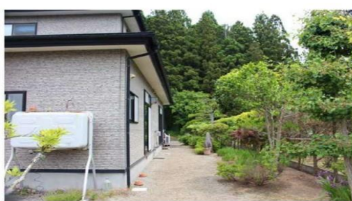
⑫建物南側境界の西端より
