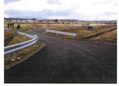
農作業道の整備
