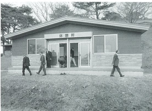
完成した国花苑休憩所
