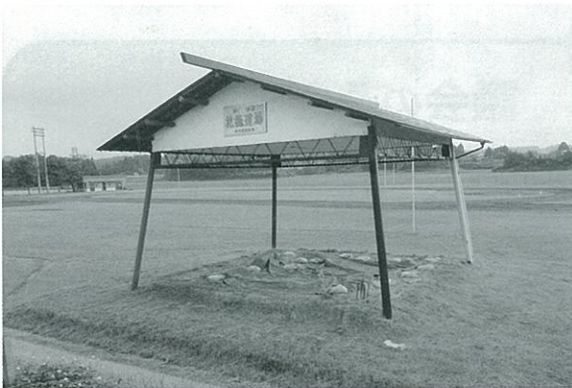
解体される「花籠道場」
