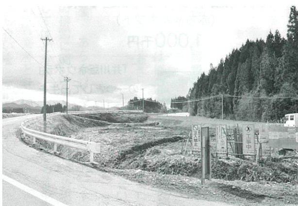
寺沢地内道路工事
