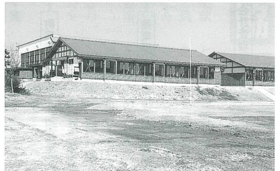
増設された教室棟
