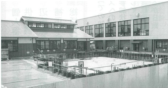
基礎工事中の給食調理施設
