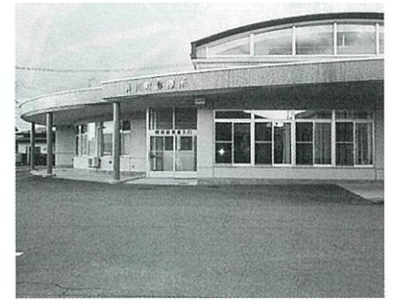
診療所等の屋上を改修
