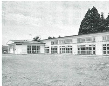
旧幼稚園舎の解体
