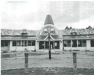
老人福祉センター屋根・外壁改修
