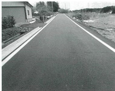
大野地金山線舗装補修
