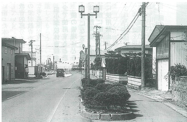
経年劣化により更新 (田中・羽立町内)
