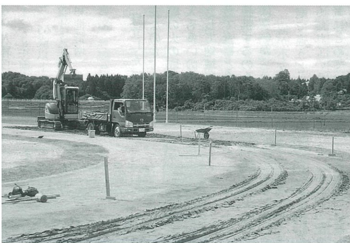
義務教育学校グラウンドトラック改修工事
