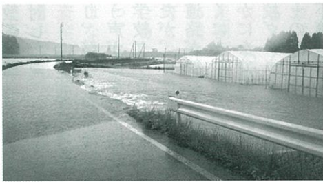
大雨で浸水した道路とビニールハウス
