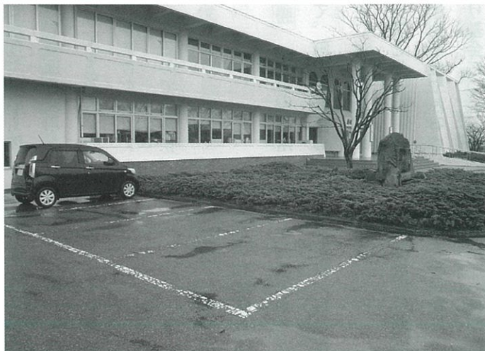
環境センター駐車スペース
