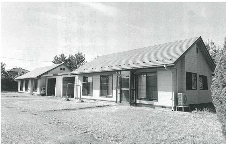
解体が決まった特別賃貸住宅（羽立町内）
