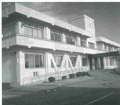
外壁改修で明るくなった庁舎
