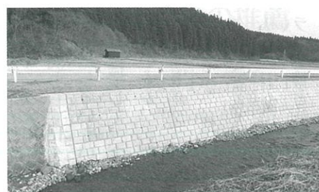
大麦地内道路災害復旧
