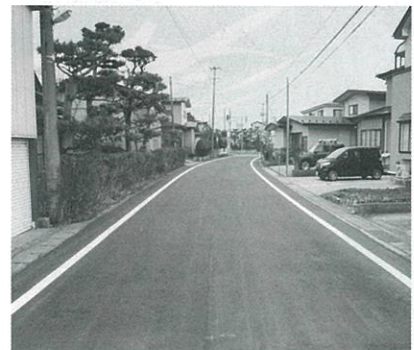
田中町内町道の道路補修
