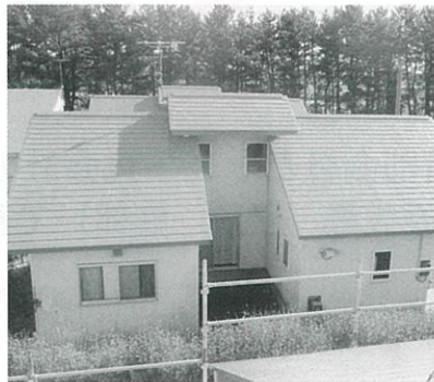
屋根塗装を終えた街道町営住宅
