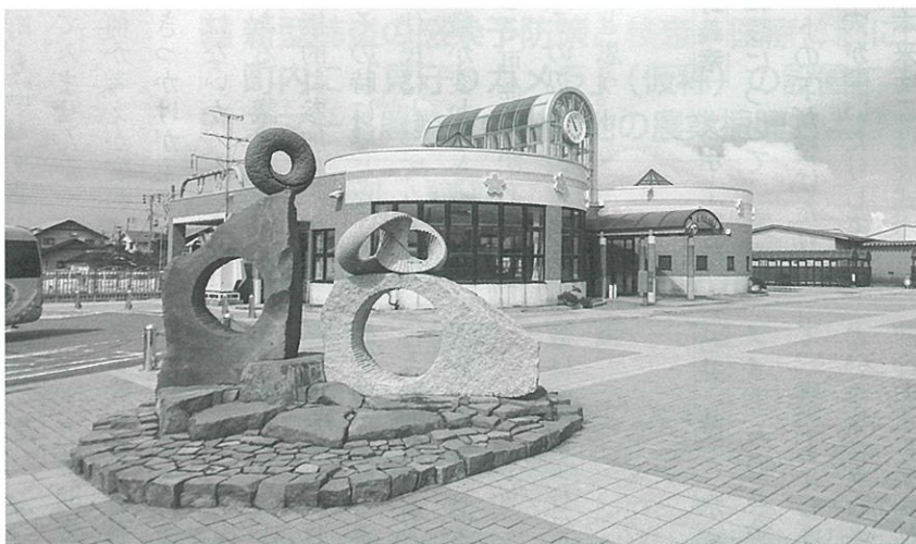
井川の玄関口である井川さくら駅
