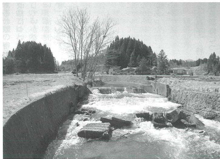
工事がはじまる施田頭首工
