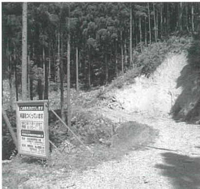
工事が進む林道 施田～黒坪線
