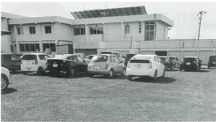
整備が望まれる駐車場
