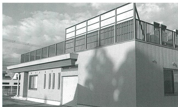
新設されたみなくるの防音フェンス
