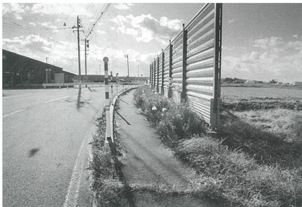
雑草により幅が狭くなった歩道
