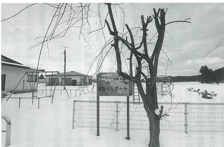
大規模災害時には危険箇所となる井内運動公園施設
