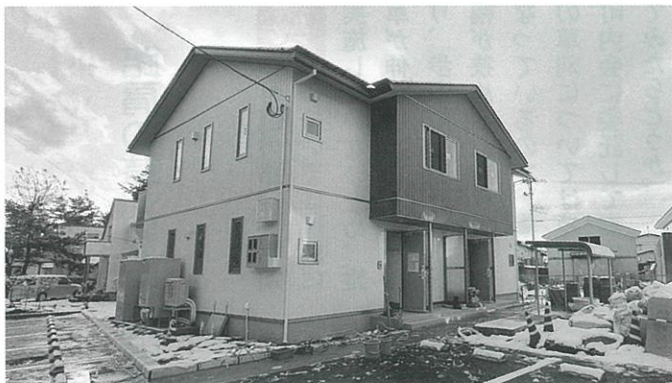
完成間近の定住化促進住宅
