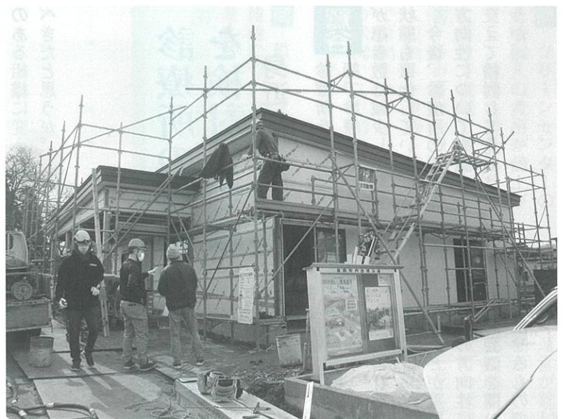
建設が進む横岡防災センター
