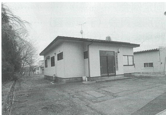
改築される綱木沢生活改善センター
