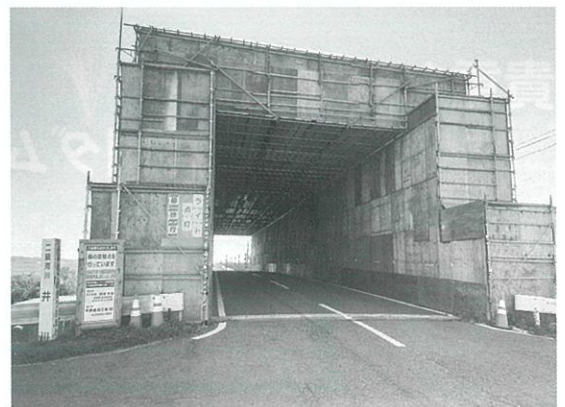
干潟橋改修工事
