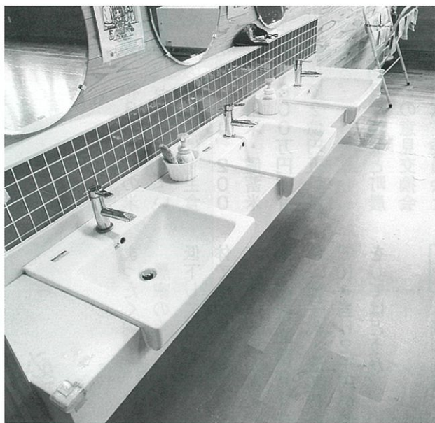
まだ自動水栓化されていない町の施設
