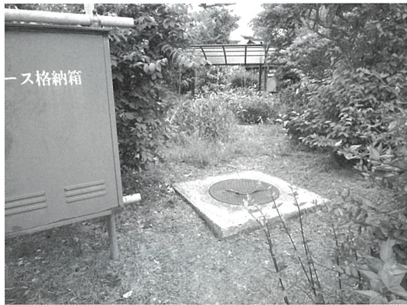
空き家状態となった宅地に設置されている防火水槽
