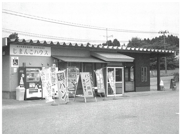
凍結防止工事が実施されるじまんこハウス
