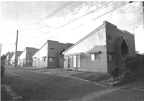
町営住宅外壁改修・解体等
