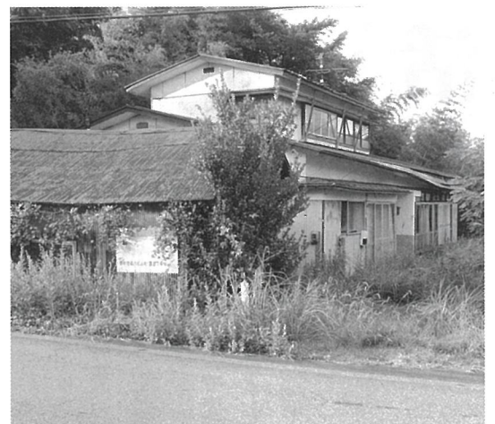
放置されている空き家
