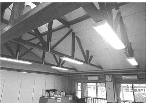
プール改修・LED化工事等
