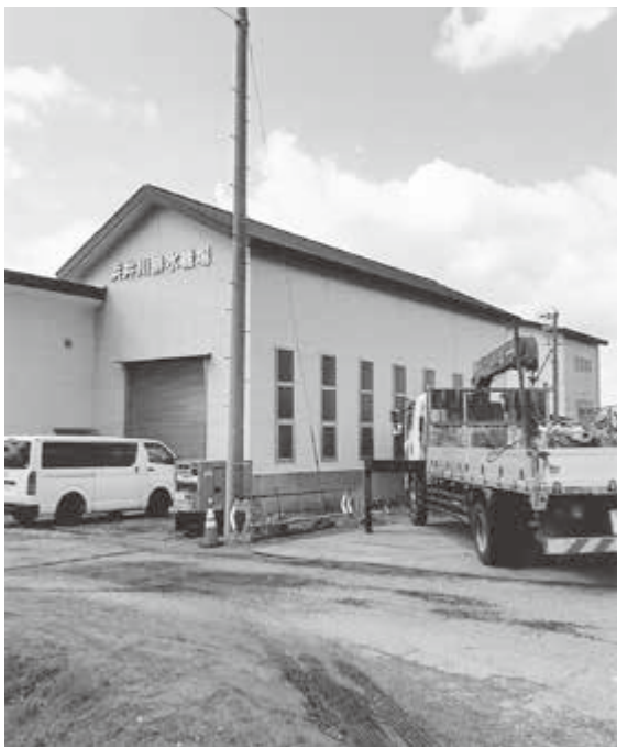
負担割合が気になる排水機場
