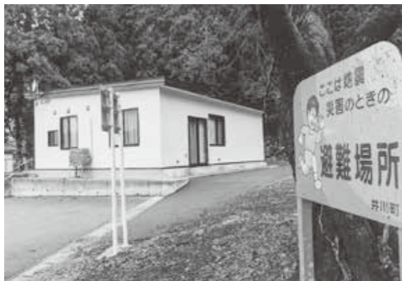
大台地区防災センター
