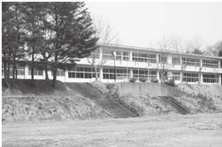
解体が予定されている旧井川小学校
