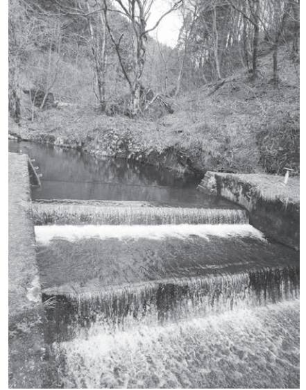
上水道3水源のうち大又沢取水源
