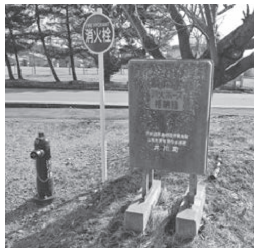
順次撤去される消火ホース格納箱
