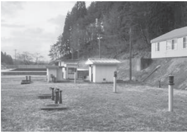
井川町浄水場
