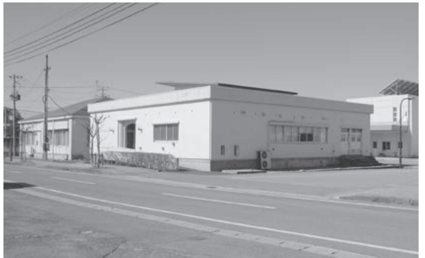
備蓄倉庫建設予定地（旧歯科センター）
