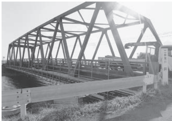
干潟橋橋梁補修工事（防災安全事業）
