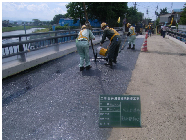
「橋面防水工：橋面防水層散布状況」
