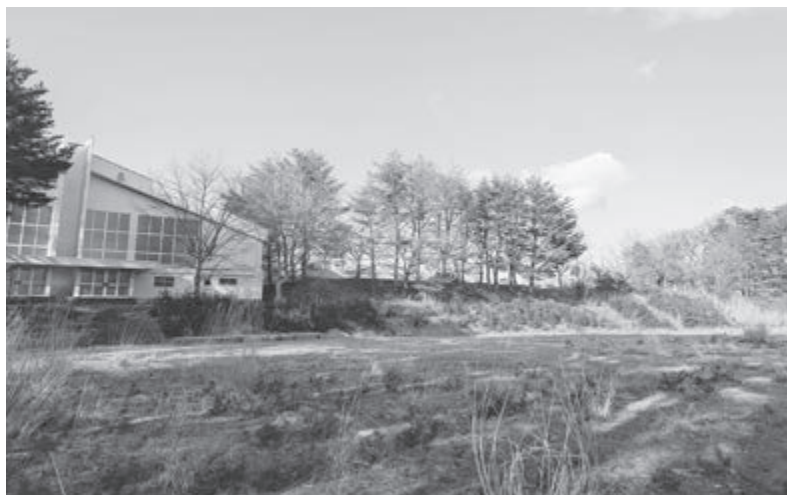
解体が進む旧小学校
