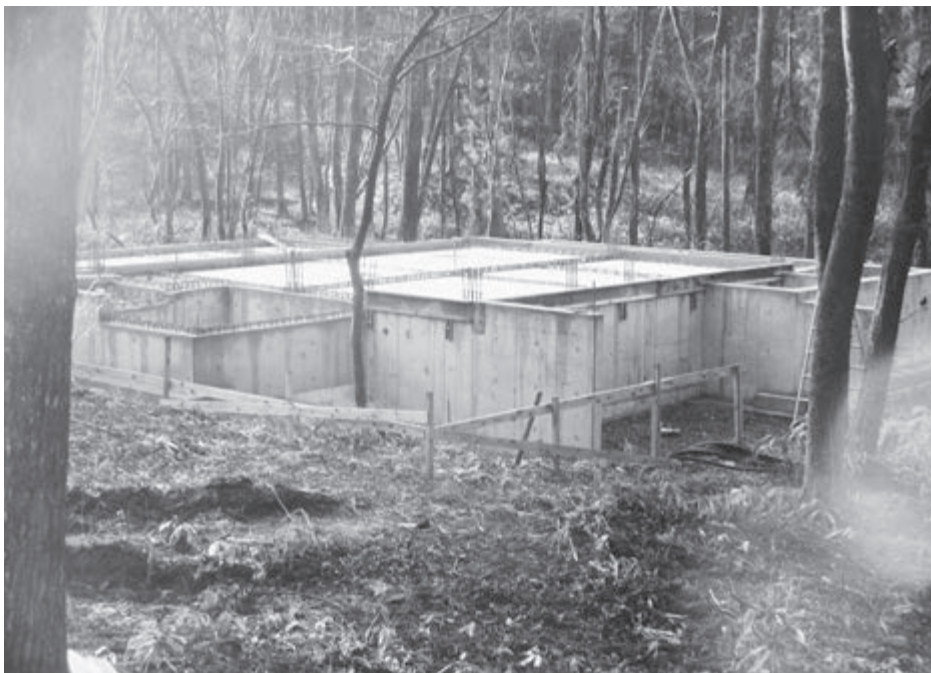
宿泊棟建設現場（4月1日現在）
