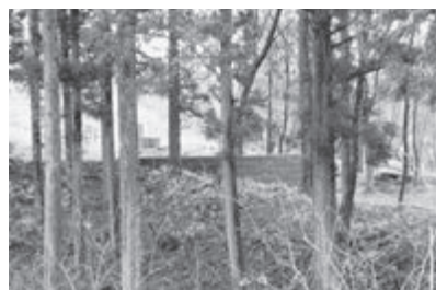
工事が進む宿泊棟
