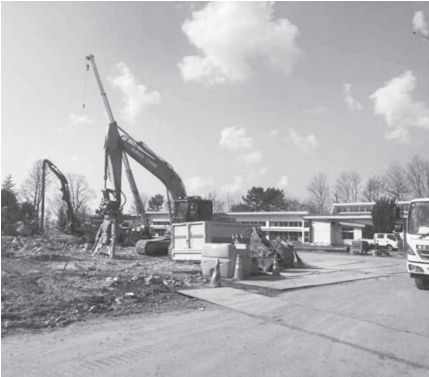
跡地の活用は（旧小学校解体現場）
