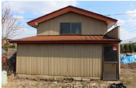
⑮居宅側から小屋
