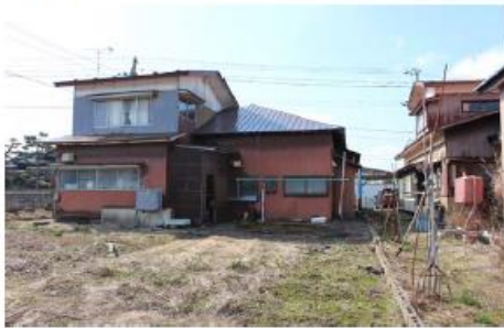
⑯小屋側から
