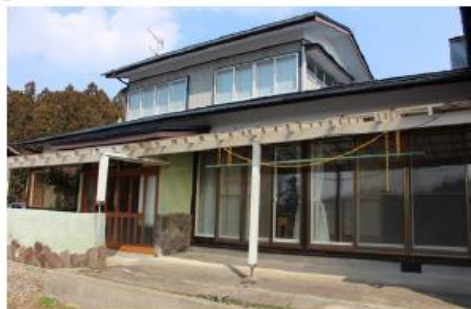
② 同（建物南側から）
