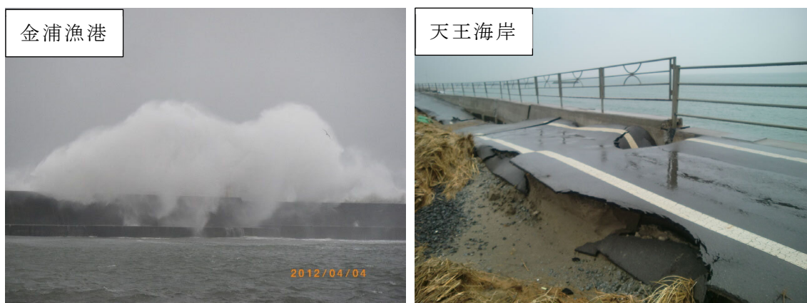
図-1 平成 24 年 4 月低気圧の被害状況
